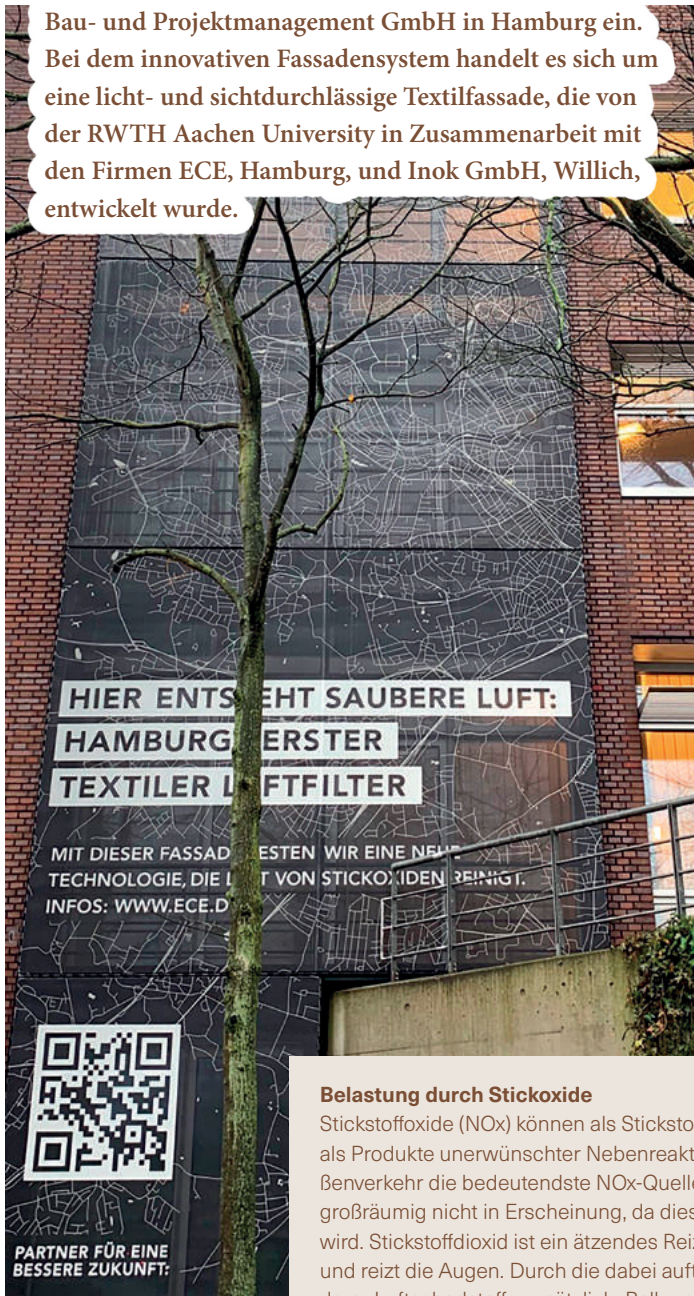
Bild: © ITA, Jan Serode Erste Anti-NOX-Textilfassade am Hamburger ECE-Gebäude ermöglicht Stickoxid-Reduktion
